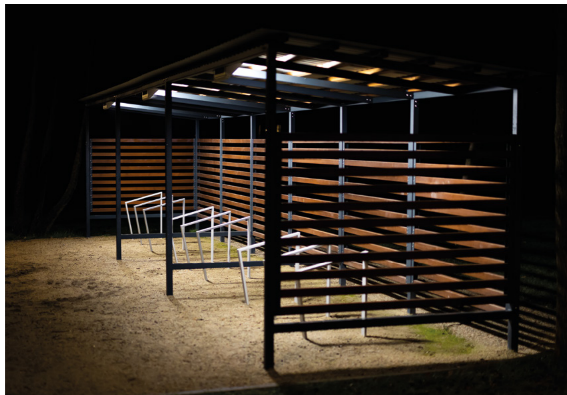
Exemple d'éclairage adéquat pour un abri-vélo à l'extérieur
